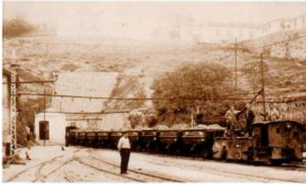
Foto 13. Locomotora saliendo del túnel Naya (Archivo F.R.T.)
