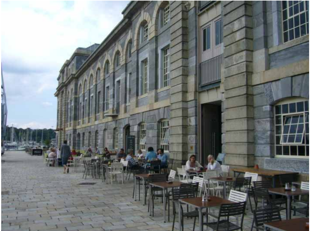
Figura 7: Intervención de rehabilitación en las antiguas instalaciones militares de Royal William Yard en Plymouth.
