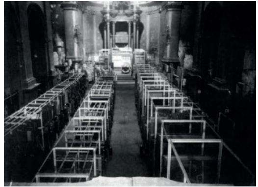
2. Habilitación de depósitos acondicionados 7
