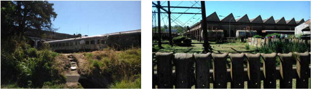
Figura 7. Predio de los Talleres Ferroviarios Mechita.
