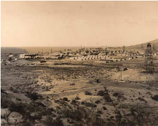
Foto 3: Vista de Km 3
