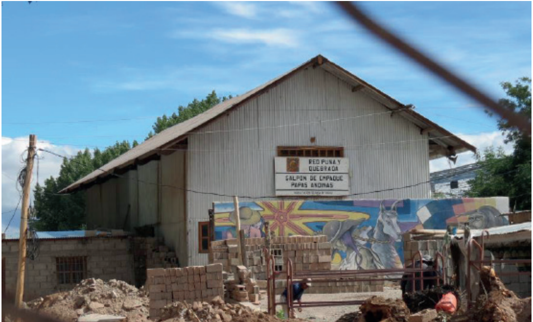
Figura 8: Galpón ferroviario. Estación Humahuaca.
