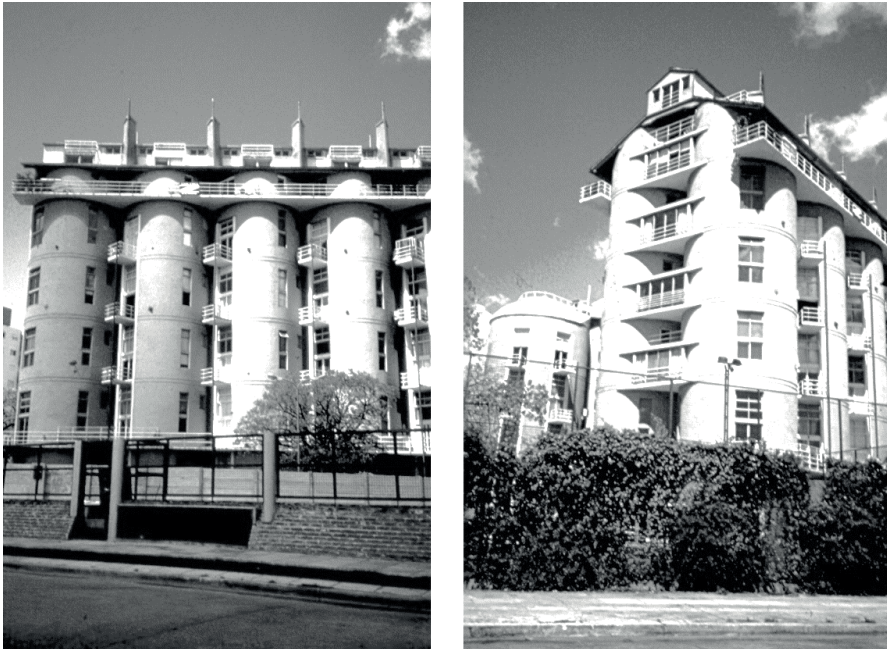
Figura 3: Recuperación para uso residencial de un antiguo silo en Buenos Aires, Argentina
