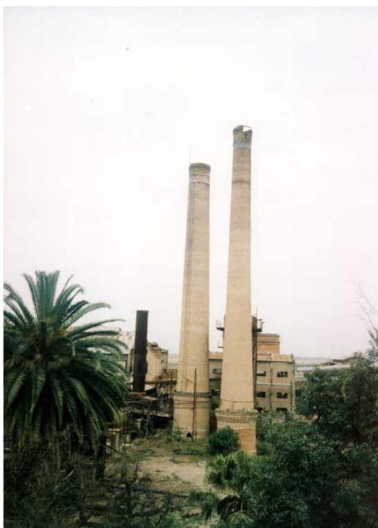
Foto 1. Chimeneas del ingenio de San Pablo.
