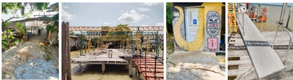
Painel 2 - Da esquerda para a direita: vista do acesso à área de embarque/desembarque; obras no píer; banheiro acessível; rampa de acesso à plataforma flutuante com guarda-corpo.
