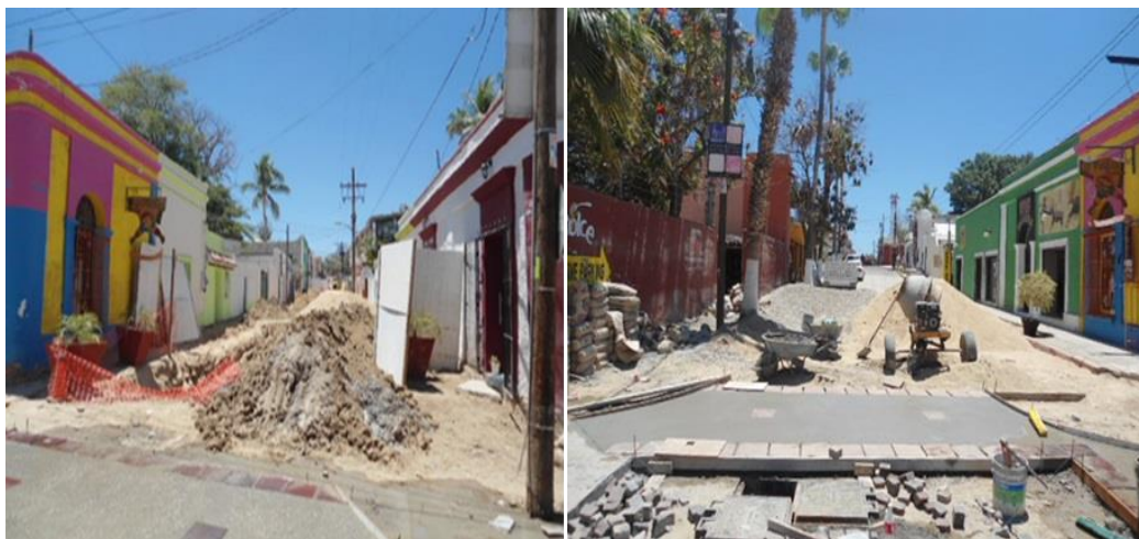
Fig. 6. Obras de regeneración cruce calles Álvaro Obregón y Miguel Hidalgo, 2014
