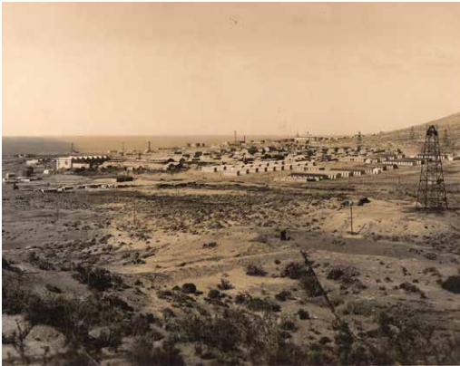
Foto 3: Vista de Km 3
