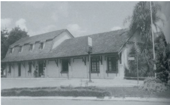
(c) Fachada norte.
