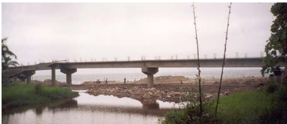
Imagen 17. Nuevo puente peatonal turístico sobre el río Cuale.
