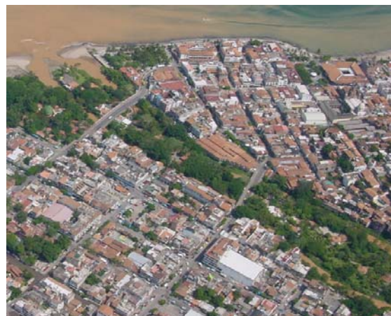
Imagen 16. Panorámica de la isla del río Cuale y puentes.
