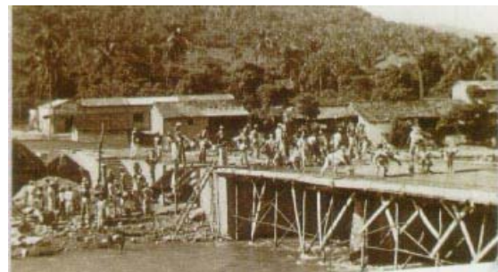
Imagen 15. Primer puente vehicular sobre el río Cuale.
