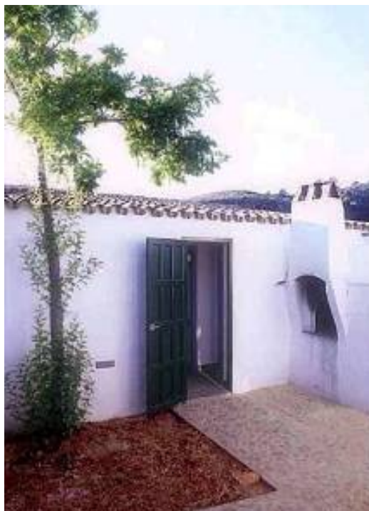
Figura 8. Casa del Horno.
