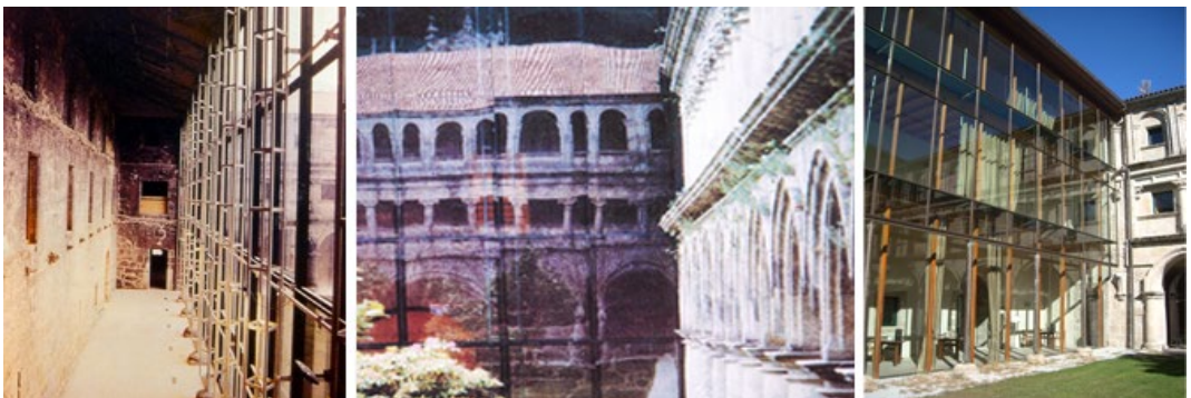
Fig. 3: Detalles del muro cortina existente en el Claustro Grande, en 1990, 1993 y 2011.
