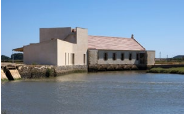
Figura 15: Estado final. Vista general. 2007
